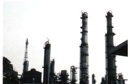
●コンビニートなどの広大敷地内 ●工場や倉庫の構内
