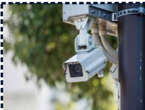
防犯カメラ設置工事
