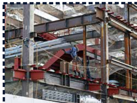
高所作業現場
