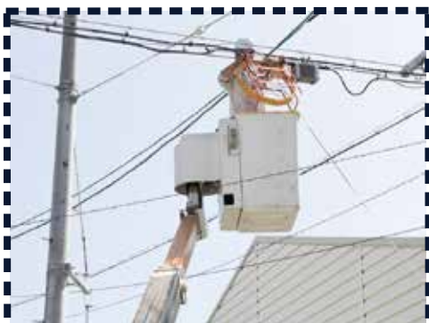
電気や電話・LANの配線設置工事
