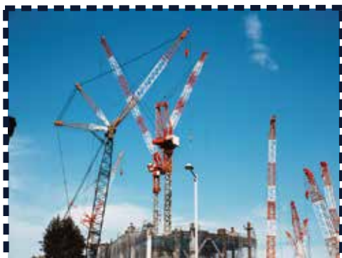
クレーン作業現場
