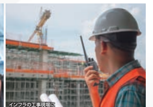
インフラの工事現場に
